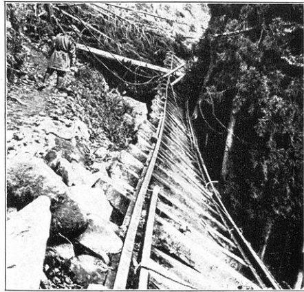
Fig. 10. Zerstörung einer Bahnstrecke am steilen Hange im Hakone-Bergland, Japan 1923.
