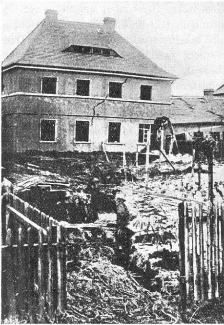
Fig. 2. Hauszerstörung durch Erdspalte im Senkungsfeld über einer zusammenbrechenden Schlotte
