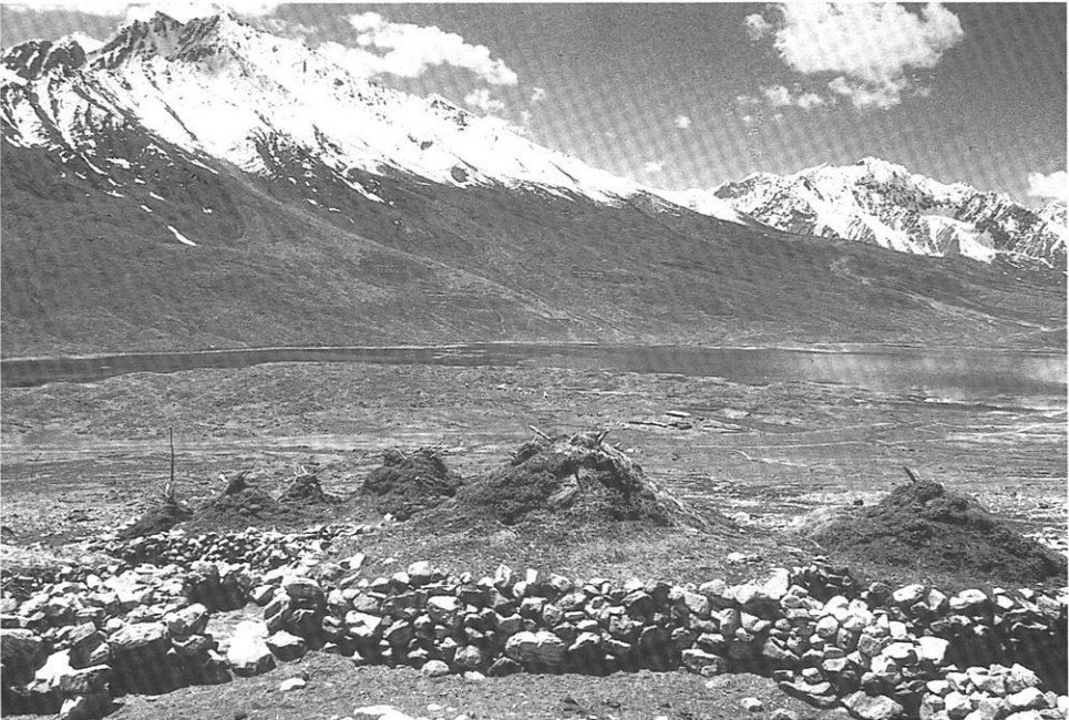
Photo 14: Saisonal genutzte Weidesiedlung Mahurampal am Shandur An. Die aus Weidenholz ( Salix ) konstruierten Dächer der Wohngebäude werden mit Dornpolsterpflanzen (vorwiegend Acantholimon ) und Bodenmaterial gedeckt (Aufn.: 18.6.1997, Standort: 3720 m)
